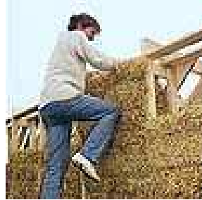
Figure 11 : Maison montée en botte de paille.
