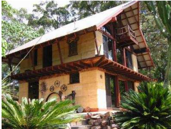
Figure 13 : Maison construite en terre compressée.
