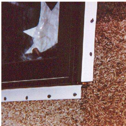
Figure 14 : Brique en copeaux bois-ciment.
